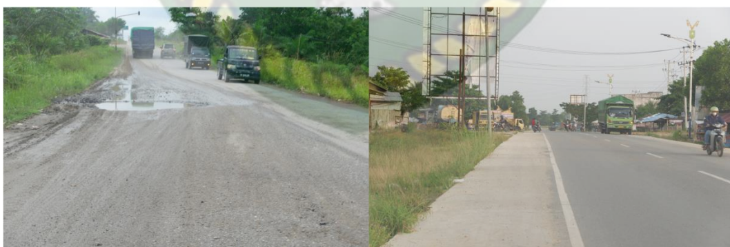
Gambar 5. 6 Kondisi Lokasi Segmen 3 (Dokumentasi, 2021)
