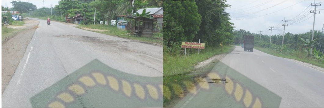
Gambar 5. 8 Kondisi Lokasi Segmen 4 (Dokumentasi, 2021)
