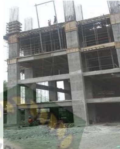
4. Pengangkutan besi balok menggunakan mini crane
