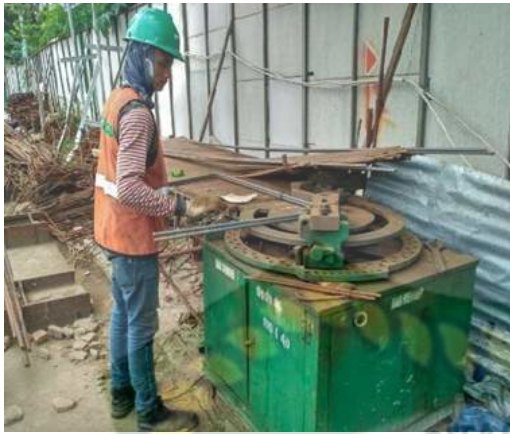
3. Pembengkokan besi balok menggunakan Bar Bender
