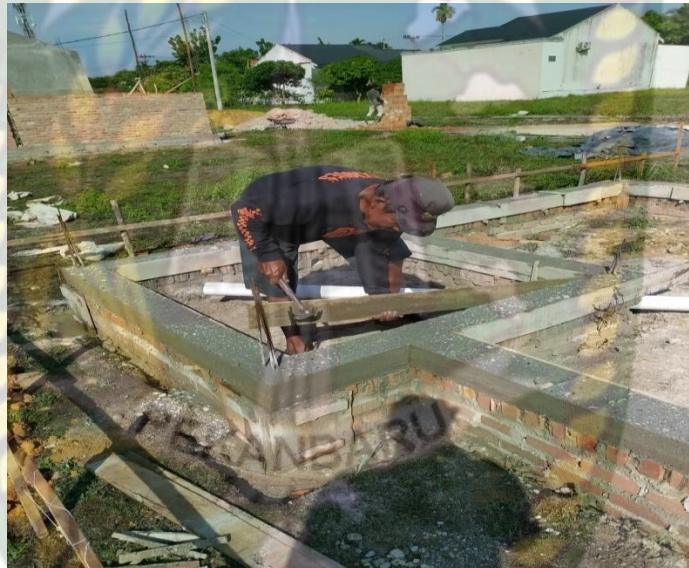
Gambar 5.5 Pekerjaan Pembongkaran Bekisting Balok Sloof
