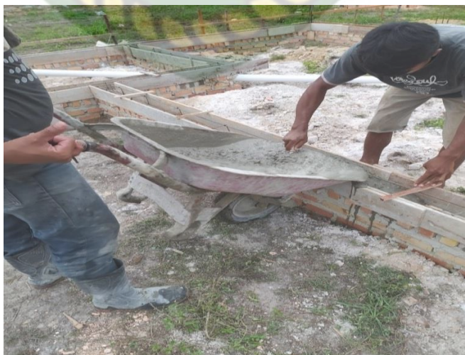
Gambar 5.4 Pekerjaan Pengecoran Balok sloof
