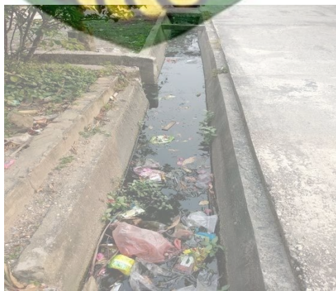
Gambar 5.7 Drainase Tidak Mampu Mengalirkan Limpasan Air Sumber: Hasil Survei Primer 2021
