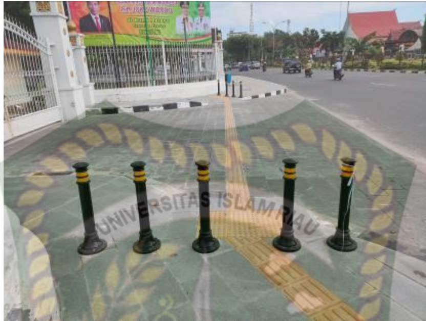
Gambar 5.13 Kondisi Jalur Pejalan Kaki yang ramah Disabilitas di Jl.
