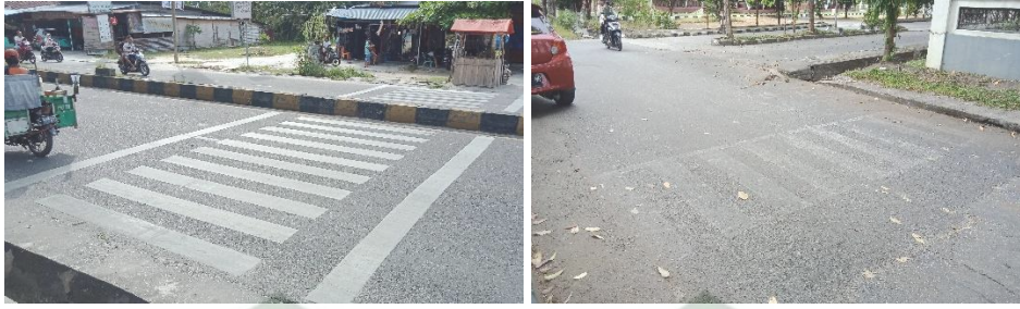
Gambar 4.4 Kondisi Fasilitas Penyebrangan
