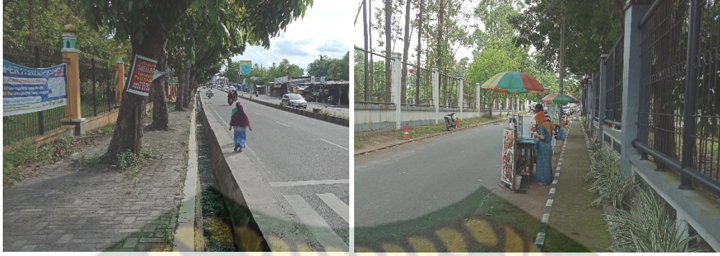
Gambar 4.2 Kondisi Jalur Pejalan Kaki
