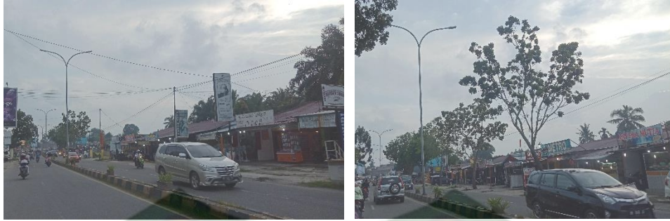
Gambar 5.5 Kondisi eksisting Lampu Jalan yang berada grid – 1 (Jalan Kaharuddin Nasution)
