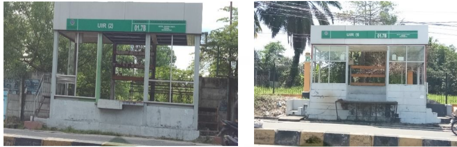
Gambar 5.8 Kondisi eksisting Halte atau shelter bus yang berada di grid 1 (Jalan Kaharuddin Nasution)
