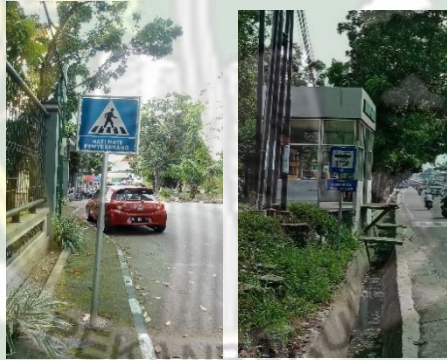
Gambar 5.7 Kondisi eksisting Rambu/marka yang berada Universitas Islam Riau
