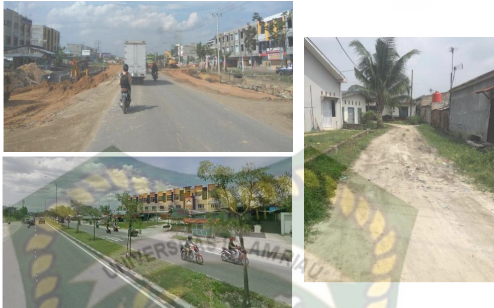
Gambar 4.10 Kondisi jalan berupa konstruksi/ permukaan tanah yang tersebar di Kecamatan Tampan
