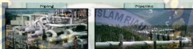
Gambar 2.1 Perbedaan piping dan pipeline (Sumber: Erinofiardi, 2014)
