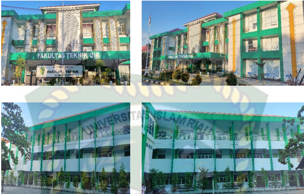
Gambar 2.1 Gedung Ruang Dosen Dan Kelas Teknik Geologi
