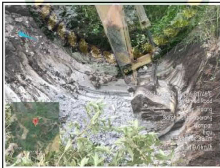
Gambar 4.19 Proses Pemboran menggunakan Eskavator
