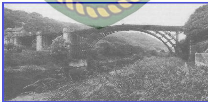
Gambar 3.5 Jembatan besi pertama (Nrendra Taly,2014)
