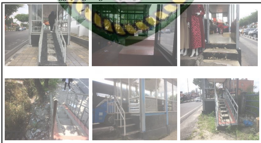
Gambar 4.1. Kondisi Ramp Halte
