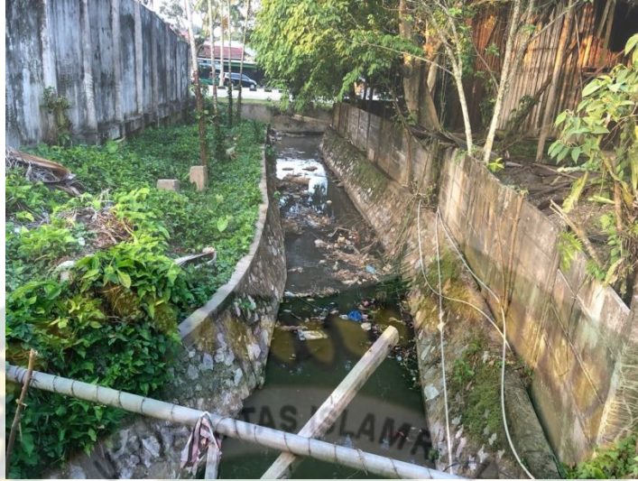
Gambar 5.4 Tidak Terpeliharanya Drainase di Desa Koto Taluk Sumber: Hasil Survei Primer 2020
