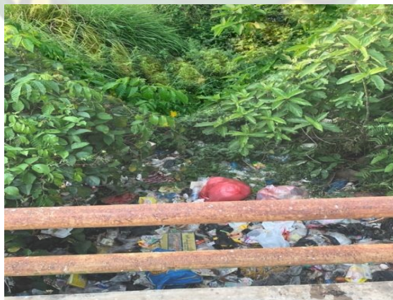
Gambar 5.15 Tidak Terpeliharanya Drainase di Desa Sawah Sumber: Hasil Survei Primer 2020
