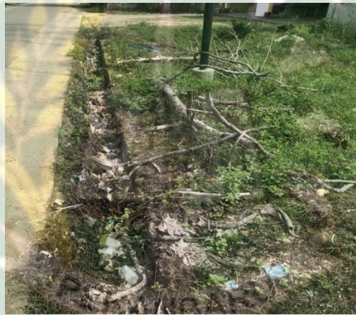
Gambar 5.16 Kualitas Kontruksi Drainase di Desa Sawah Sumber: Hasil Survei Primer 2020
