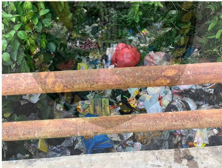
Gambar 5.22 Kondisi Tidak Terpeliharanya Sarana Dan Prasarana Pengolahan Persampahan di Desa Sawah
