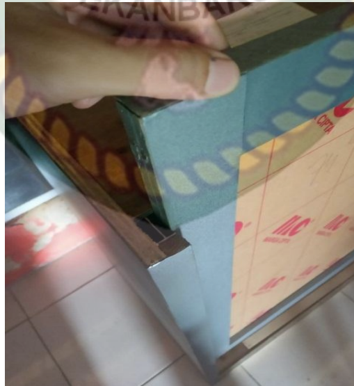
Gambar 3.8 Pemasangan slide jendela kerja lemari asam
