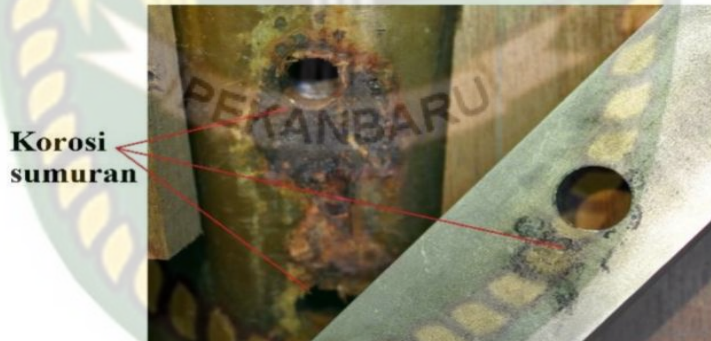
Gambar 2.6 korosi sumuran (Cramer dan Bernard, 2003)
