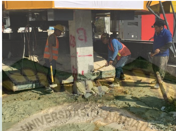
Gambar 5.7. Pemotongan Tiang Pancang (Dokumentasi, 2019)
