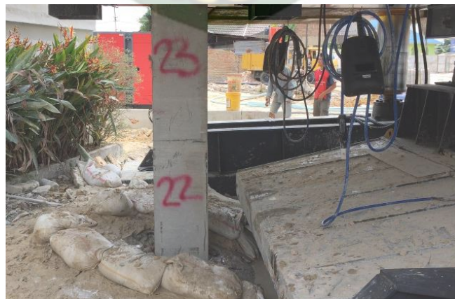
Gambar 5.5. Penekanan Tiang Pancang (Dokumentasi, 2019)
