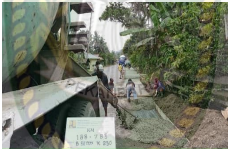
Gambar 19. Pengerjaan Beton Mutu K-250 (Sumber : PT. Hasrat Tata Jaya)
