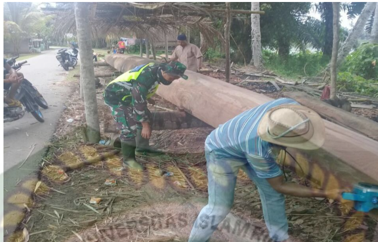
Gambar 15. Proses Menghaluskan Jalur
