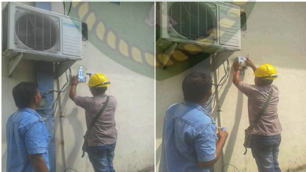
Gambar V.1 : Petugas PLN Tidak Menggunakan Peralatan atau Safety Saat Melakukan Pasang Baru Listrik Prabayar
