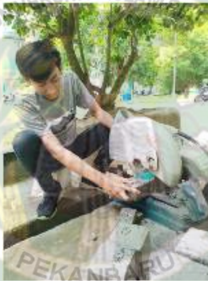
Gambar 4.19 Pemotongan Paving Block (Dokumentasi Penelitian)
