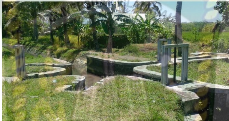
Gambar 3.7 Bangunan Sadap (Aikmual, 2014)
