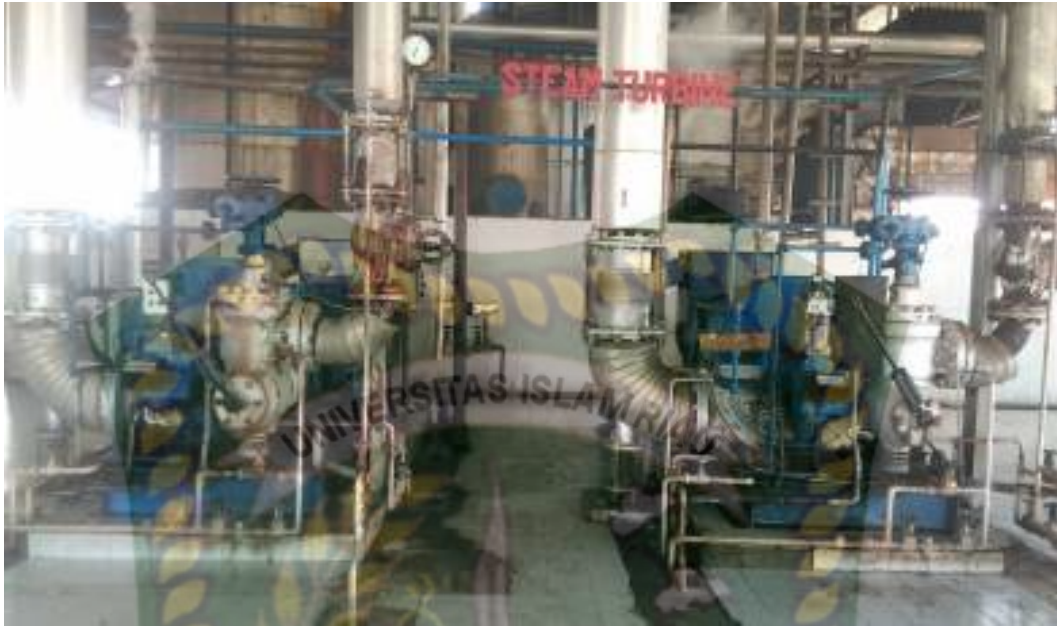
Gambar 2.1 Turbin Uap (Sumber :PT Perkebunan Nusantara V Sei Pagar)
