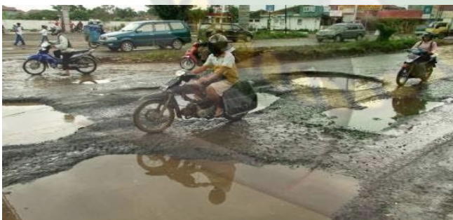
Gambar 17. Jalan Rusak Sumber: vevnews.com
