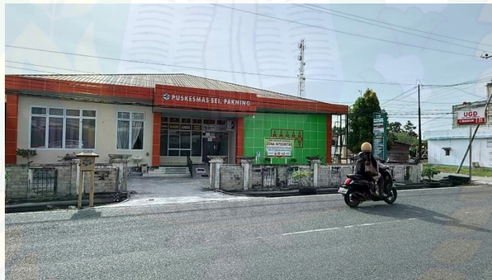
Tampak Depan Gedung UPT Puskesmas Bukit Batu sebagai Fasilitas Pelayanan Kesehatan Tingkat Pertama bagi Masyarakat di Kecamatan Bukit Batu
