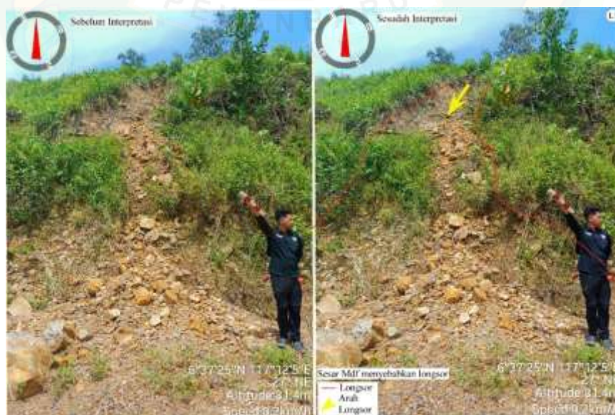
Gambar 4. 33 Foto Bukti Lapangan Longsor Pada Stasiun 10
