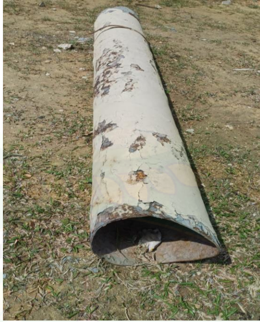
Gambar 2.5 Pipa Mengalami Korosi
