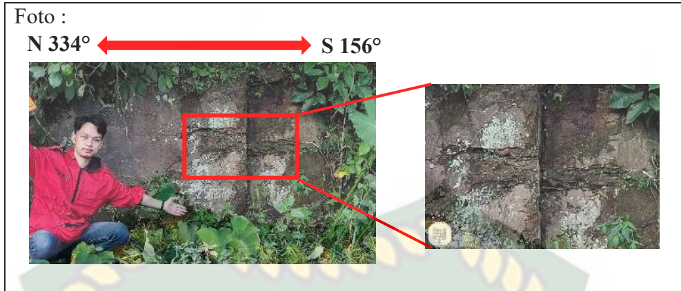
Gambar 4.3 Patahan pada Stasiun 6
