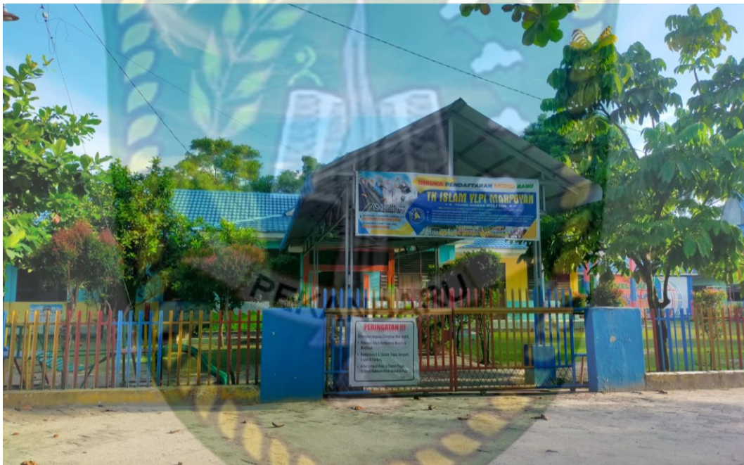
Gambar 5.1 Gedung TK YLPI
