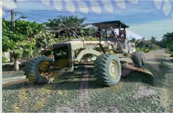
Gambar 3.1 Motor Grader (Dokumentasi Pekerjaan Lapangan)
