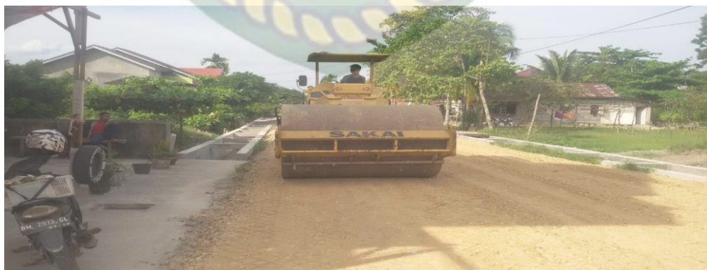
Gambar 5.4 Vibrator Roller (Dokumentasi, 2019)
