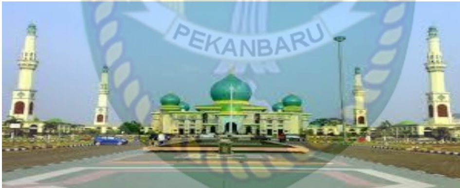
Gambar 2: Masjid Raya An-Nur Provinsi Riau Setelah di Renovasi
