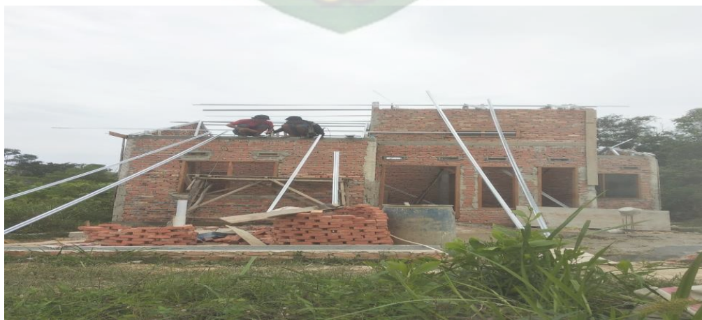
Gambar 5.3 Proses Pemasangan Reng
