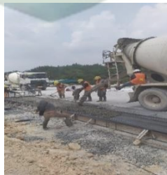
Gambar 5.6 Pekerjaan Pouring Beton (Dokumentasi, 2021)
