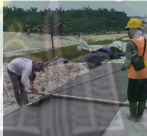
Gambar 5.11 Pekerjaan Quality Control (Dokumentasi, 2021)
