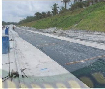
Gambar 5.13 Pekerjaan pemasangan Plastik (Dokumentasi, 2021)
