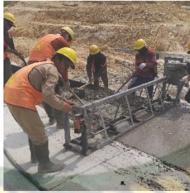
Gambar 5.9 Pekerjaan Pemadatan Beton (Dokumentasi, 2021)
