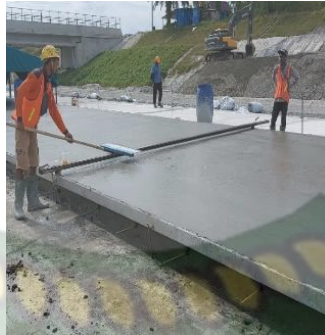
Gambar 5.17 Pekerjaan Quality Control (Dokumentasi, 2021)
