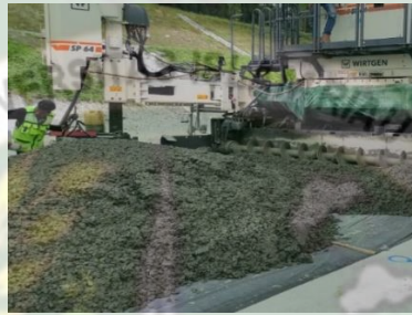
Gambar 5.16 Pekerjaan Pemadatan (Dokumentasi, 2021)
