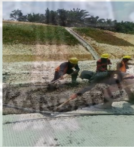
Gambar 5.7 Pekerjaan Spreading Beton (Dokumentasi, 2021)
