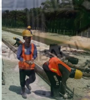
Gambar 5.2 Pekerjaan Bekisting (Dokumentasi,2021)
