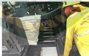
Gambar 5.14 Pekerjaan Dowel (Dokumentasi, 2021)
