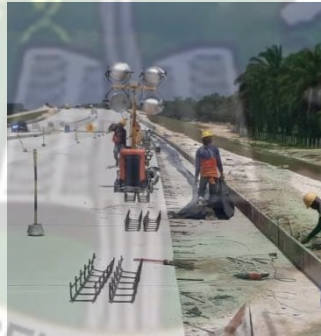
Gambar 5.3 Pekerjaan Pemasangan Plastik (Dokumentasi,2021)
