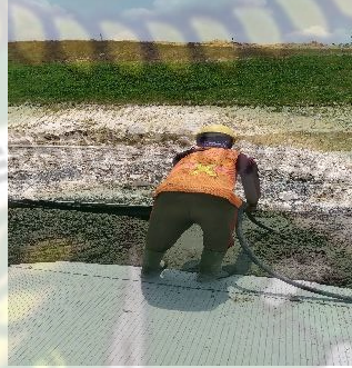
Gambar 5.8 Pekerjaan Vibrating Beton (Dokumentasi, 2021)
