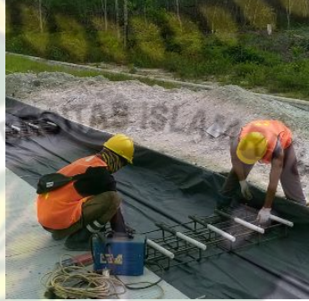
Gambar 5.4 Pekerjaan Dowel (Dokumentasi, 2021)
