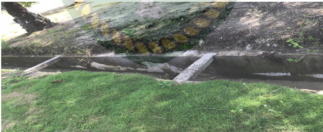
Gambar 4.2 Pembangunan Drainase RT 11
