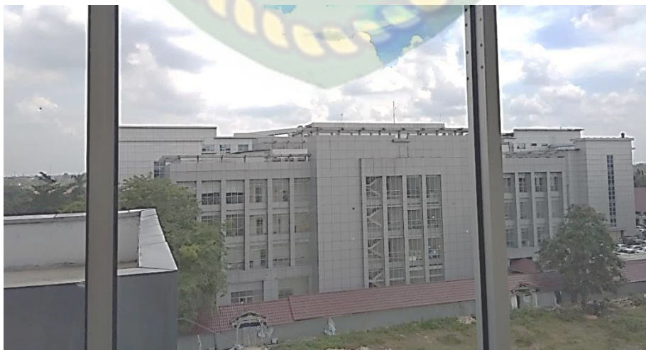
Gambar 5.6 Penampakan gedung COT dari sisi belakang
