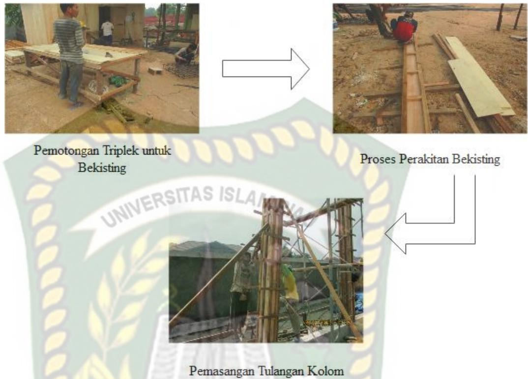
**Gambar 5.6.** Pekerjaan Bekisting Kolom (Dokumentasi, 2019)
