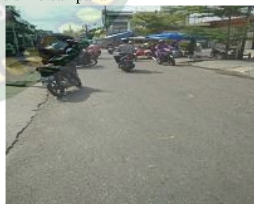
Sumber : Hasil Survy Lapangan, 2019 Gambar 5.4 Kondisi Jaringan jalan
