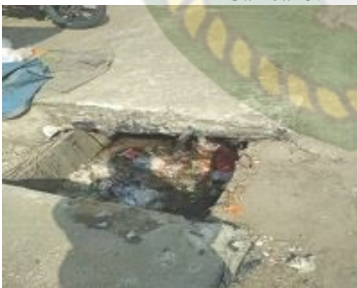
Sumber : Hasil Survy Lapangan, 2019 Gambar 5.3 Kondisi Drainase
