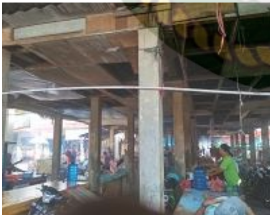
Sumber : Hasil Survy Lapangan, 2019 5.25 Gambar Kondisi Bangunan
