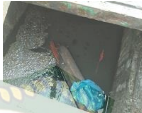
Sumber : Hasil Survy Lapangan, 2019 5.34 Gambar Kondisi Drainase
