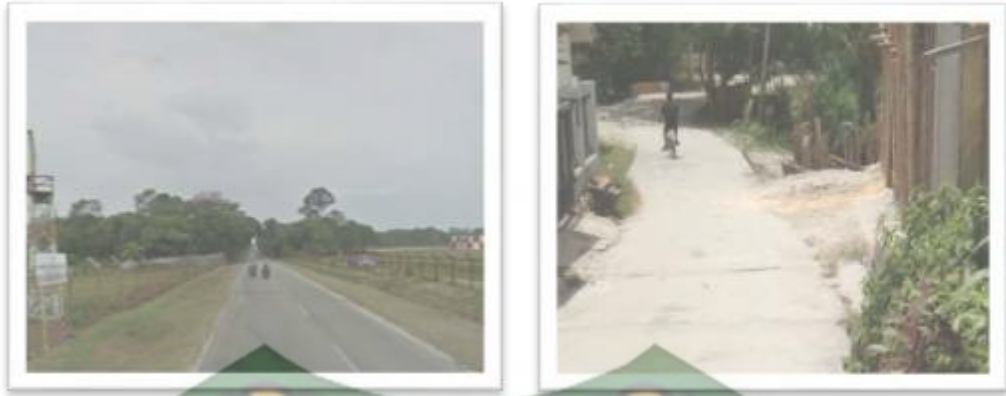
Gambar 5.10 Jalan Pada Kawasan Bahaya Kecelakaan
