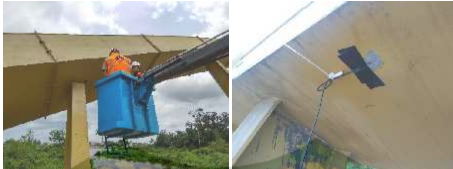
Gambar 4. 8 Pelaksanaan Pemasangan Sensor Pada Bentang Jembatan
