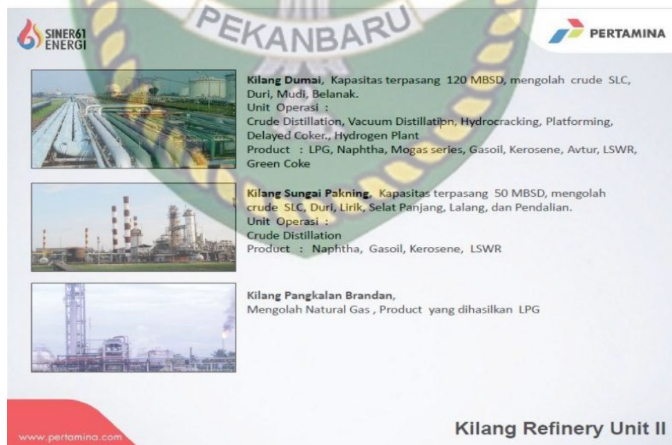
Gambar 2.2 Keadaan Kilang Persero Dumai
