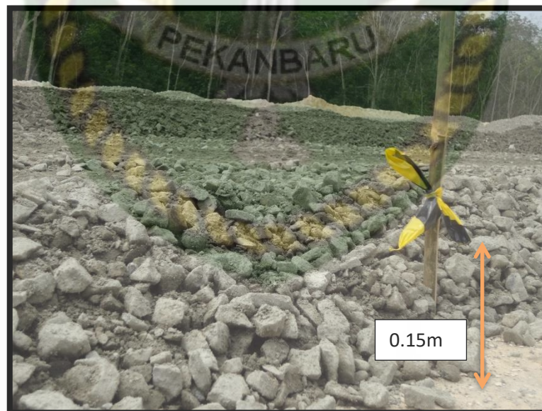
Gambar 5.16 Tebal pemadatan agregat (Dokumentasi di lapangan 2020)
