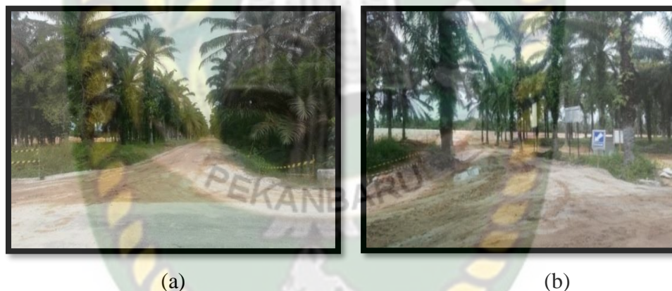
Gambar 5.20 Akses Jalan Tanah ( Sumber : Dokumentasi di lapangan 2020 )
