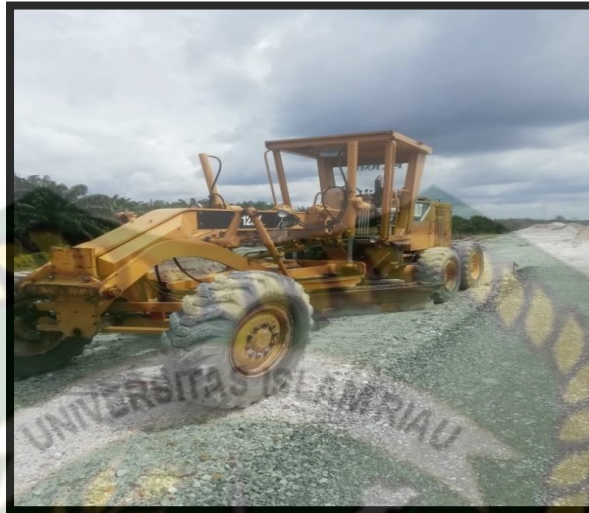
Gambar 5.11 Motor Grader Trakindo CAT 120K (Dok. Lapangan 2020)
