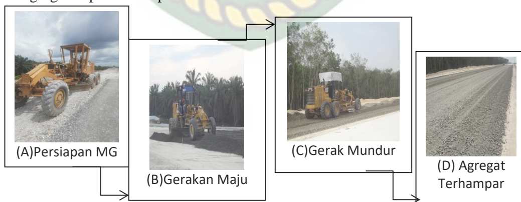
Gambar 5.5 Proses penghamparan material agregat (Dokumentasi,2020)
