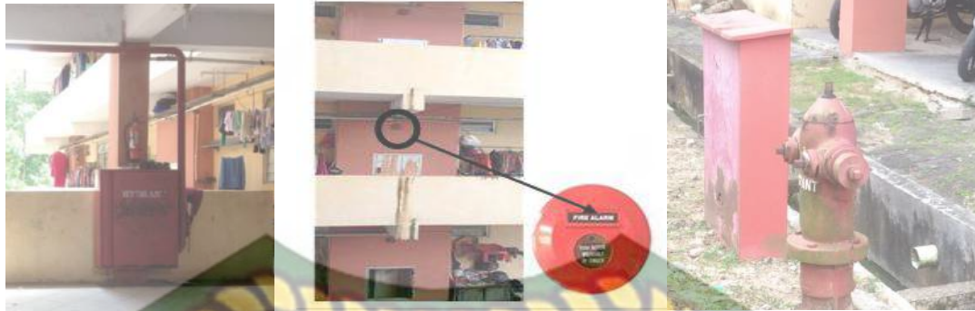
a. Hydran dan APAR b. Alarm Kebakaran c. Hydran Halaman
