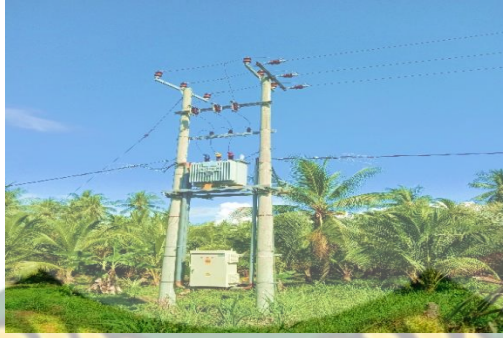
Gambar 4.16 Prasarana Jaringan Listrik Desa Kundur
