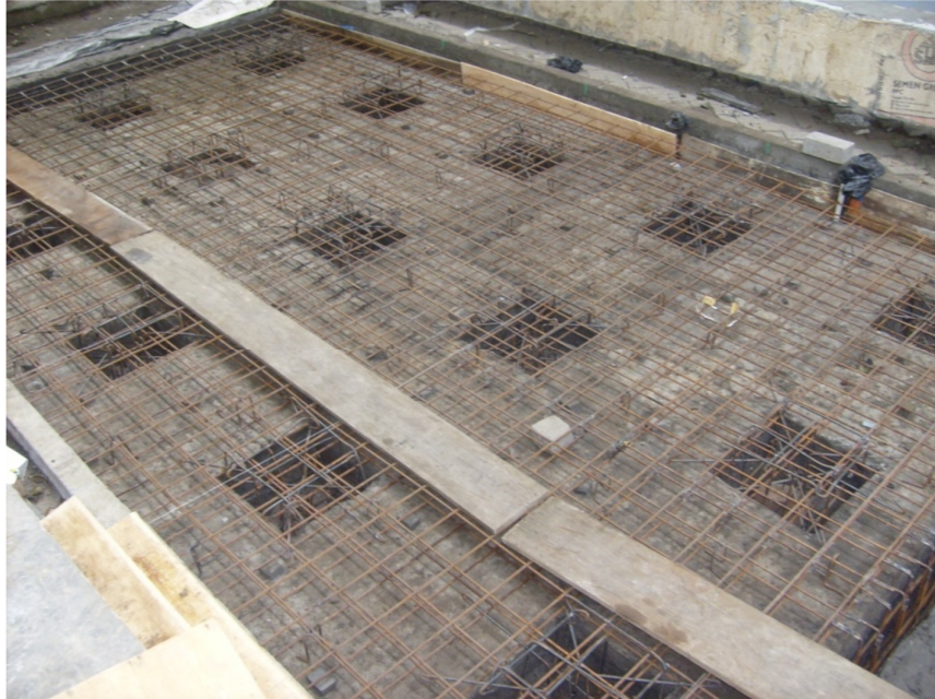
Gambar 4.6 Penulangan pelat pada Pelat Terpaku skala penuh.
