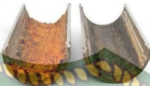
Gambar 3. 11 Pipa salur mengalami korosi
