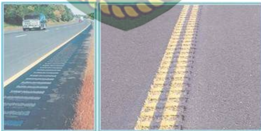
Gambar 5.14. Usulan Pembuatan continous shoulder rumble strip pada bahu jalan dan centerline rumble strips pada as jalan.
