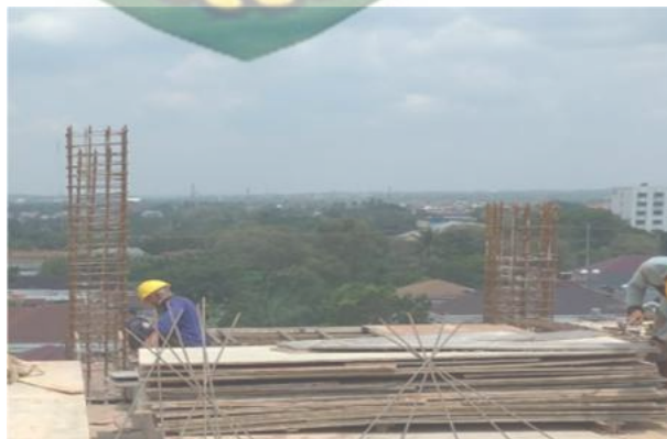
Gambar 5.3. Pemasangan Bekisting Pelat Lantai (Dokumentasi, 2018)
