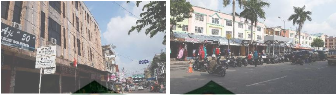
Gambar 5.7. Kondisi Eksisting Grid 5
