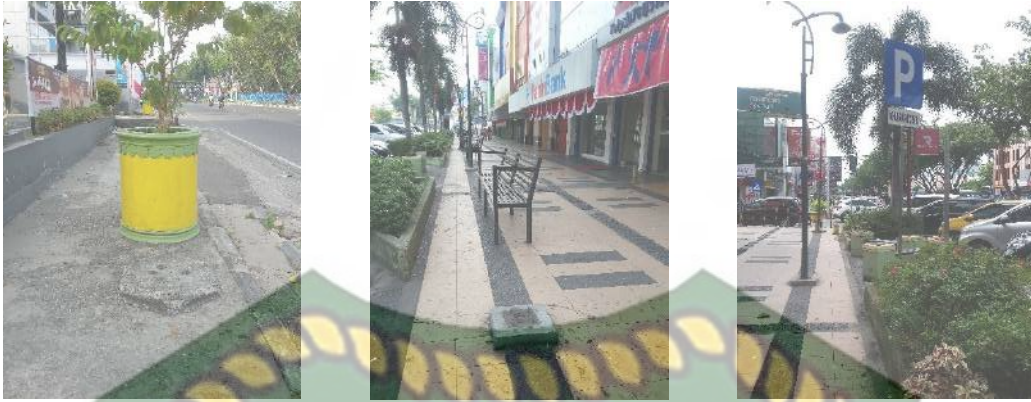
Gambar 4.5. Kondisi Fasilitas Tambahan
