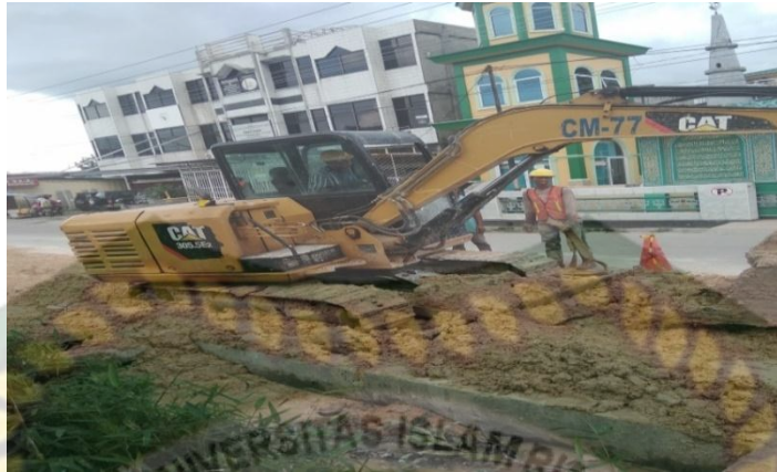
Gambar 4.3 Excavator (Dok. Lapangan, 2019)
