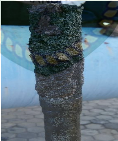
Gambar 4. 2 Scale pada kupon di Wash Tank II
